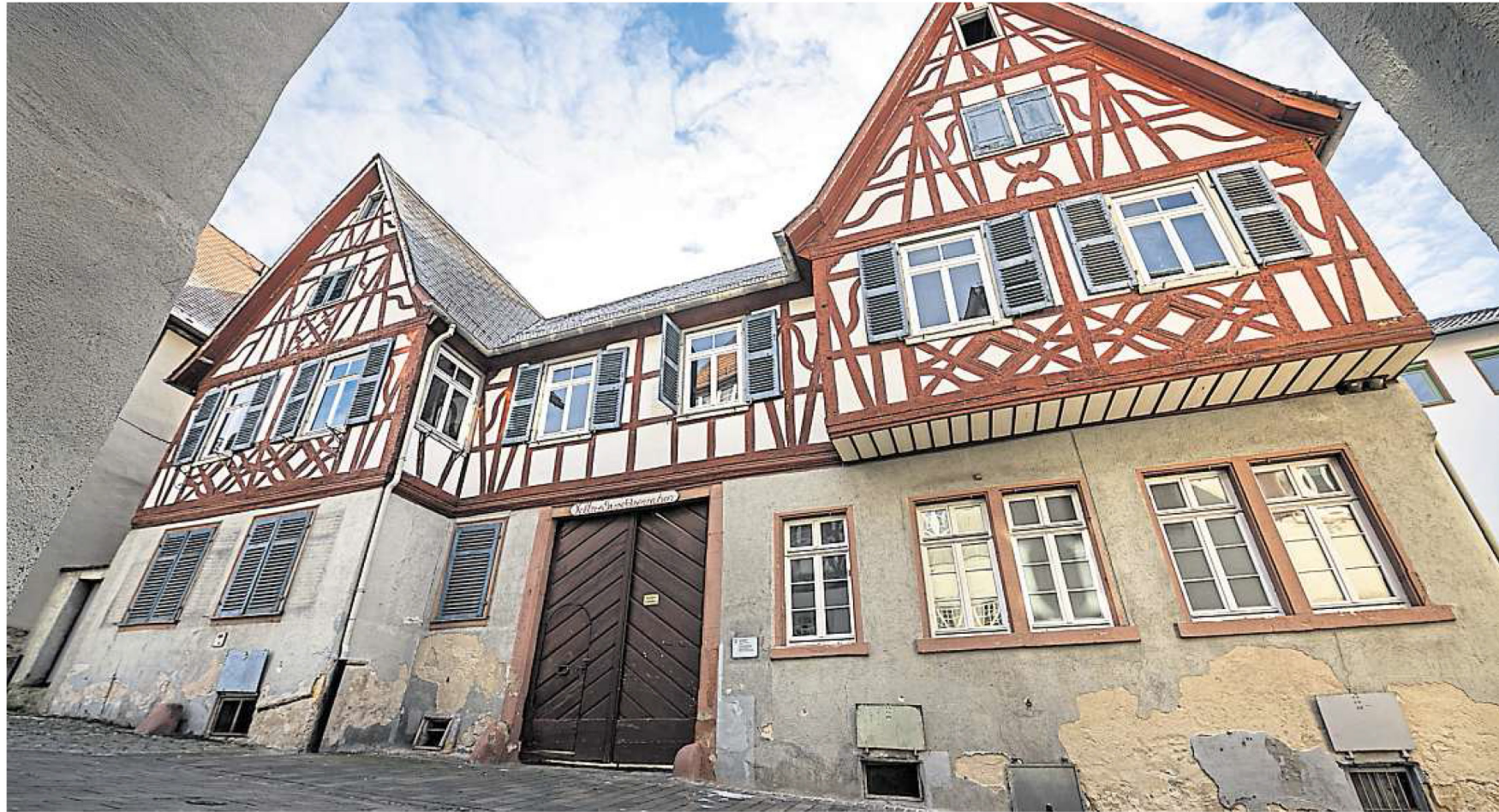
Eigentlich wollte Rennfahrer Sebastian Vettel das denkmalgeschützte Anwesen „Kellereigasse 2“ herrichten lassen und „in seiner Heimatstadt ein Zeichen setzen“. Doch daraus wurde nichts, inzwischen hat Vettel das dringend sanierungsbedürftige Haus an ein Bensheimer Unternehmen verkauft.
