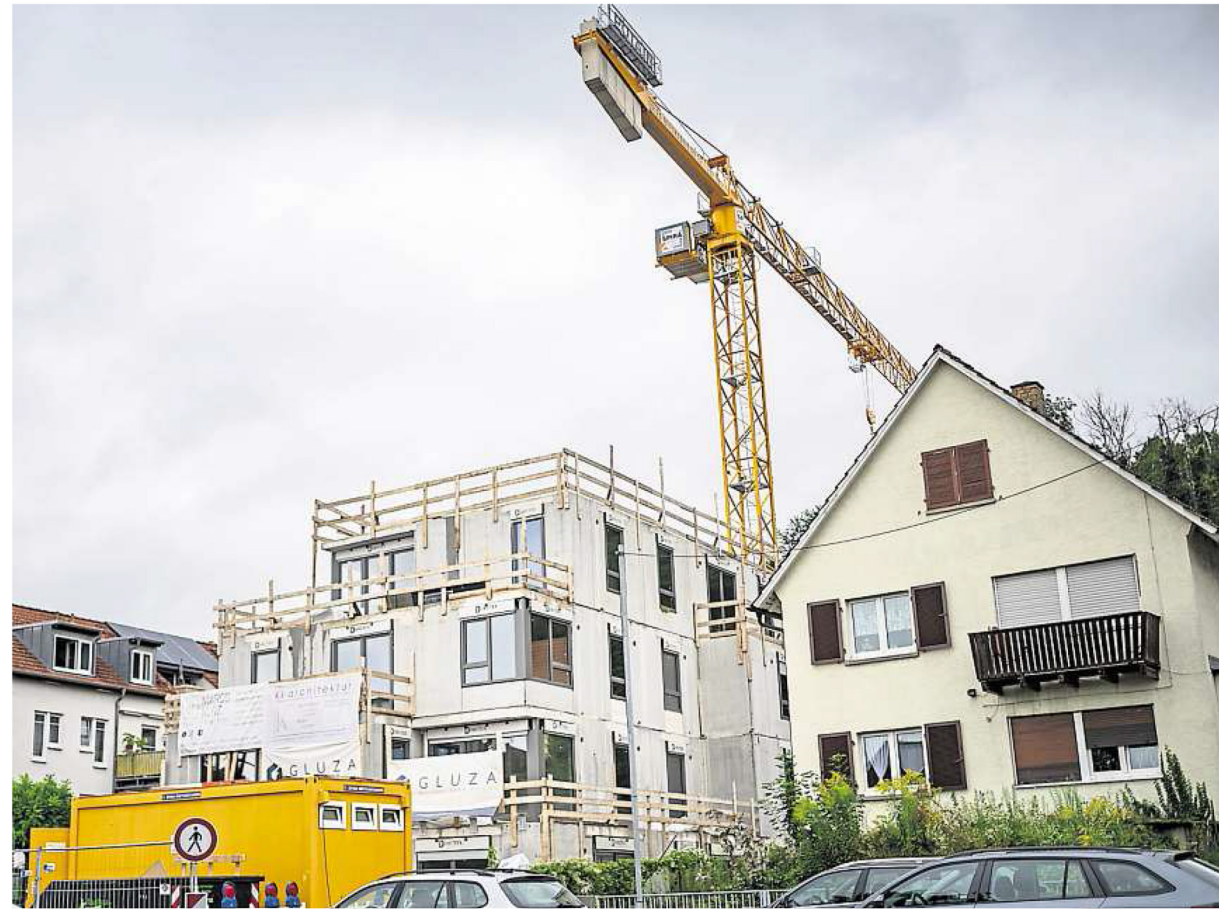
Auch mithilfe eines riesigen Baukrans schreiten die Arbeiter am Neubauprojekt „Starkenbourg-Terrassen“ schneller voran als ursprünglich geplant. Schon Anfang Dezember sollen die ersten Mieter zwischen B 3 und dem „Weißen Rain“ einziehen. Foto: Sascha Lotz
